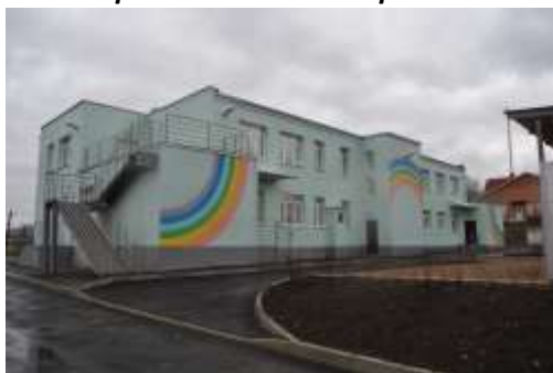
Юго-западная сторона здания
