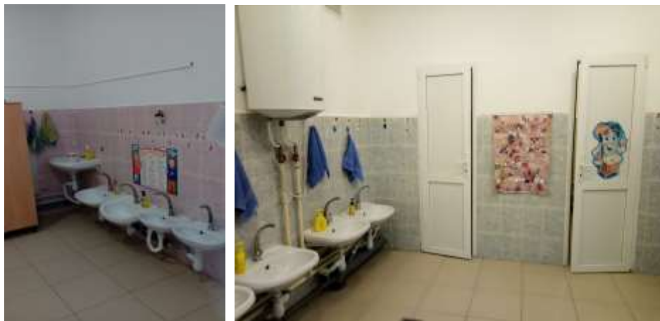
Фото № 7 (санитарно-гигиенические помещения)
